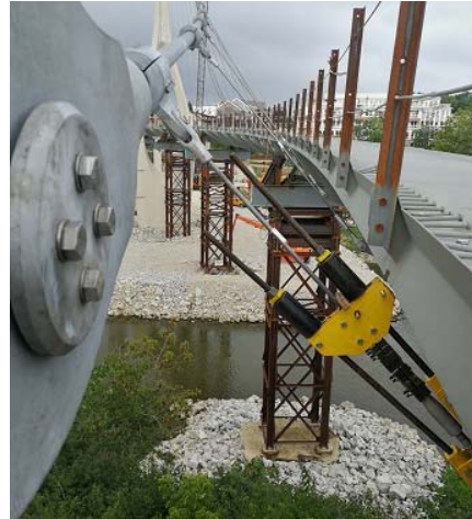
Fig. 7.8. Hangers tensioning
